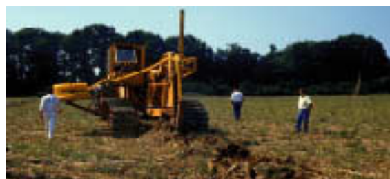
Le drainage permet de solutionner les problèmes d'hydromorphie, de stagnation d'eau.
