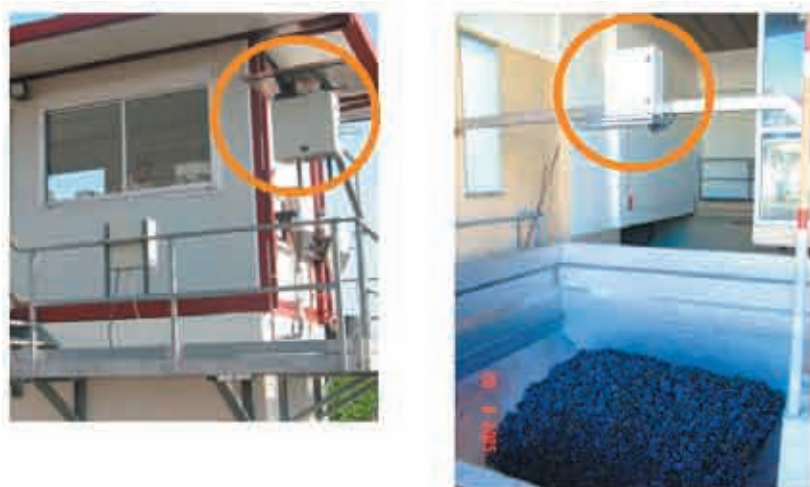
Figure 3 : exemple d'implantation de Qualiris Vision. A gauche, sur poste avancé à la cave des vigneron de Chusclan A droite, sur conquêt, à la cave des vigneron de Visan
