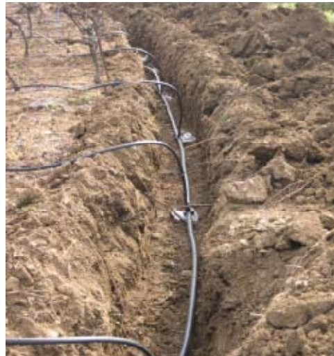
Photo 3 : le raccordement des rampes aux peignes: l'une des opérations les plus gourmandes en temps. Source Chambre d'Agriculture de l'Hérault
